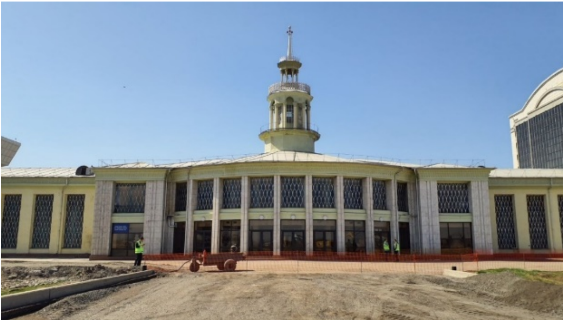
Рисунок4:4 Центральный блок здания VIP-терминала, видимый с востока
